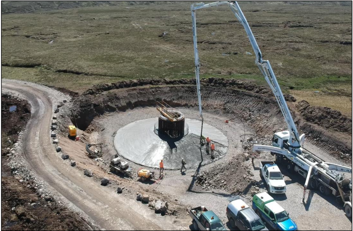
Plate 3.5: Turbine Foundation Construction – Concrete Pour
